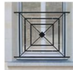
Le garde corps acier
